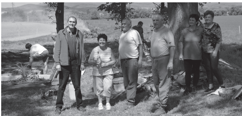
Rekonštrukcia križa v Rozvadzoch
