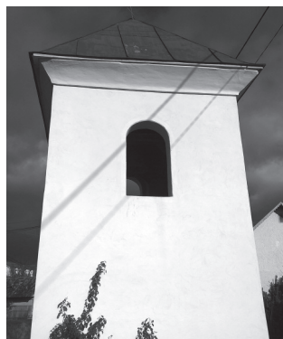
Zvonica v Rozvadzoch
