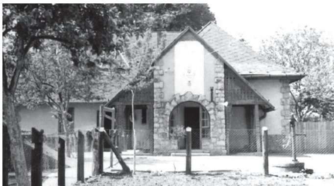
Bývalá veľkostankovská škola
